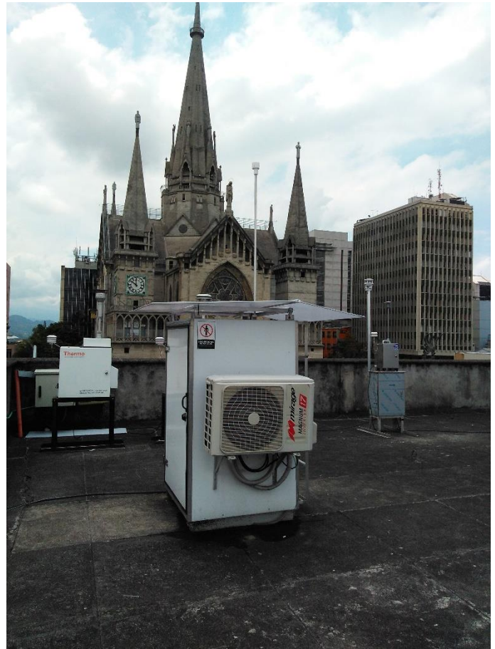
Cabina de gases, equipos de PM_{10} manual y automáticos Gobernación. Terraza licorera gobernación de Caldas
